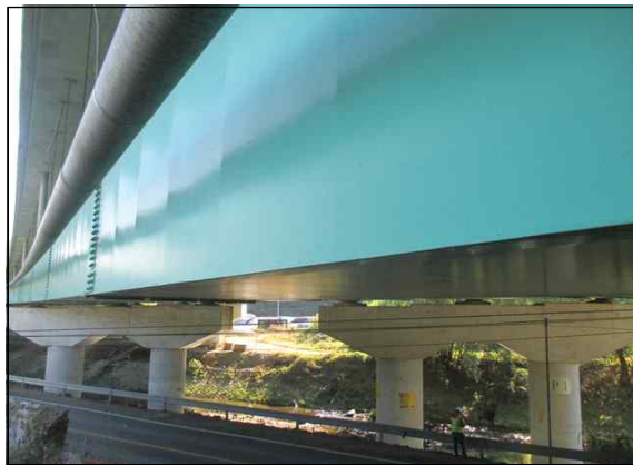
거더 외부 전경
