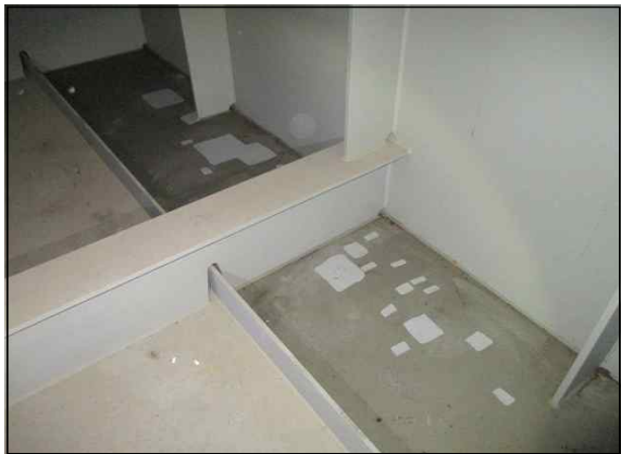
거더 내부 도장보수 현황(S3-G2)
