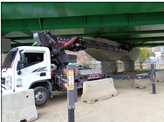
작업차량을 이용한 외관조사
