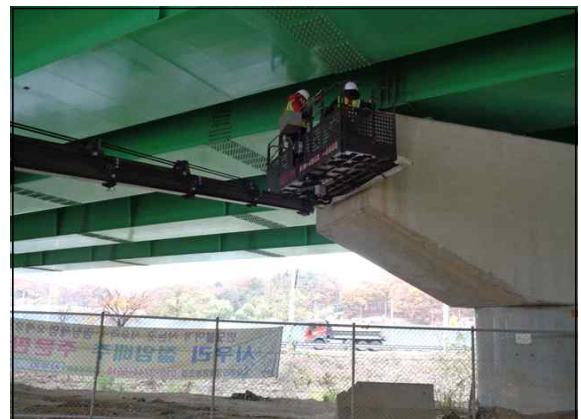
작업차량을 이용한 외관조사
