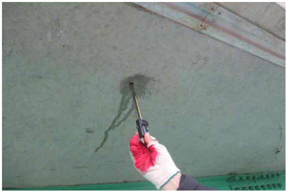
탄산화 깊이 측정현황
